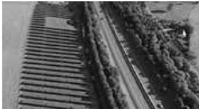
In Bergstetten / Laaber entsteht der BERR eG Solarpark
