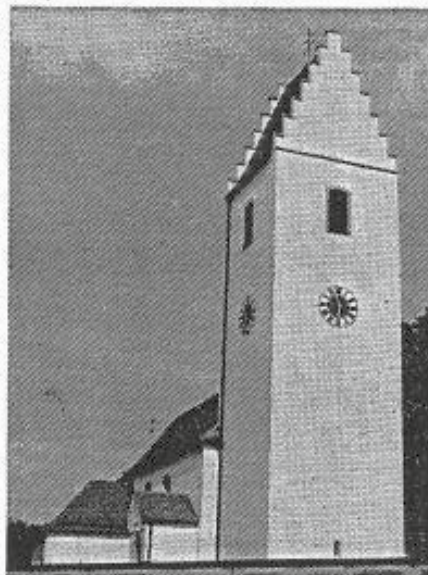
Unser Bild zeigt die renovierte Pfarrkirche in Wolkering. Aufnahme: Wagner
