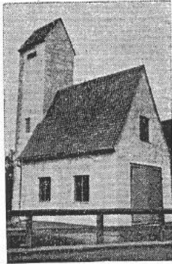
Das fertige Feuerwehrhaus mit Trockenturm in Thalmassing
