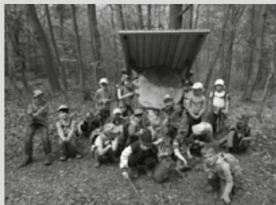
Jeder legt mit Hand an beim Bau eines Tipis
